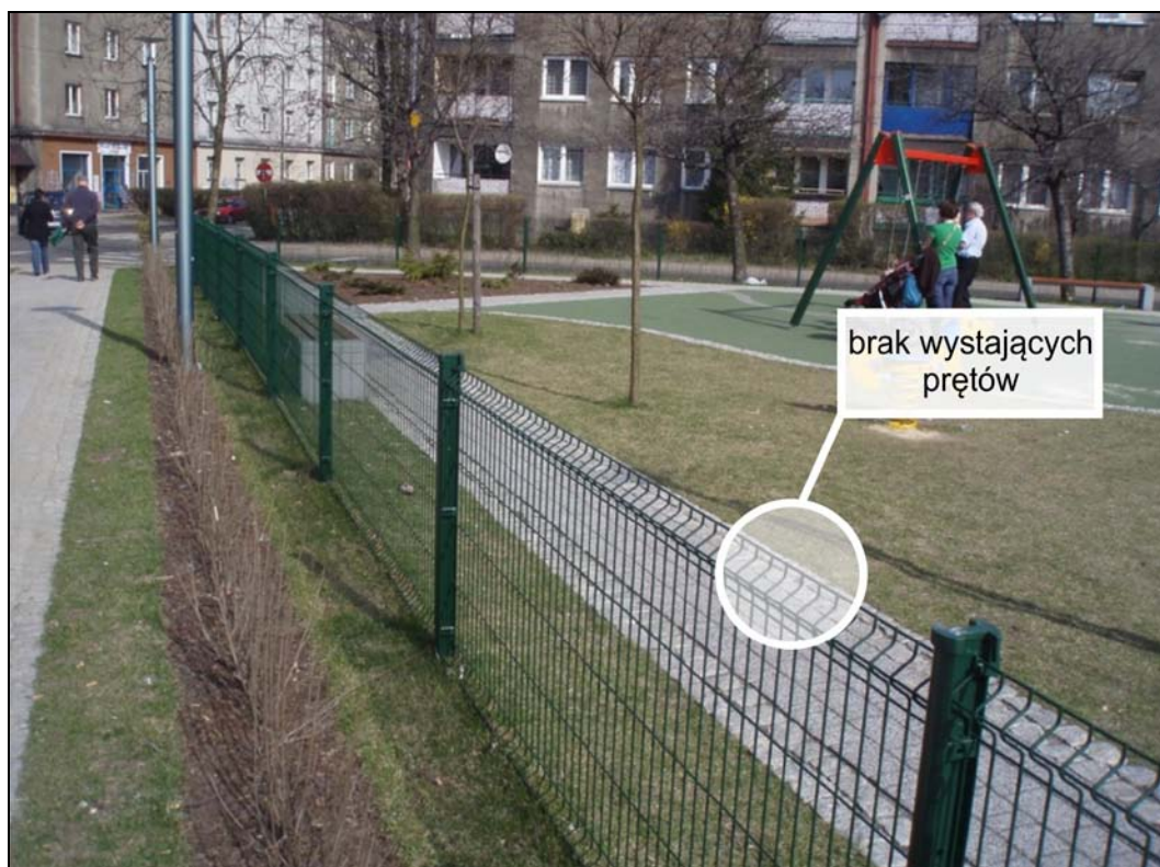
Rys.13 Projektowany typ ogrodzenia panelowego (zaznaczono miejsca gdzie absolutnie nie mogą występować pionowe pręty).
